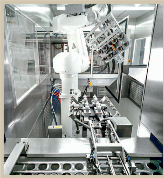
Bild 2. Ob eine kleine Reinraumzone oder ein kompletter Reinraum notwendig ist, sollte sorgfältig geprüft werden
